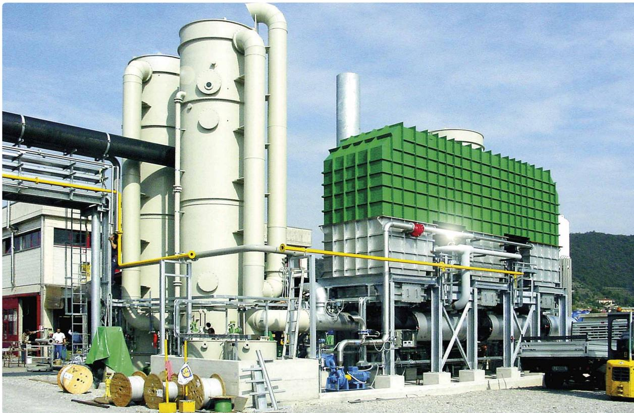
Airprotech gewährleistet eine hohe Schadstoffminderungseffizienz unter sicheren Bedingungen, indem eine geeignete Temperatur und Verweilzeit in der Brennkammer für die Oxidation von halogenierten Verbindungen aufrechterhalten wird. Neben einem hohen Grad an Prozessorientierung gewährleistet das Anlagendesign von airprotech eine hohe Zuverlässigkeit und langfristige Beständigkeit gegen aggressive Substanzen.
