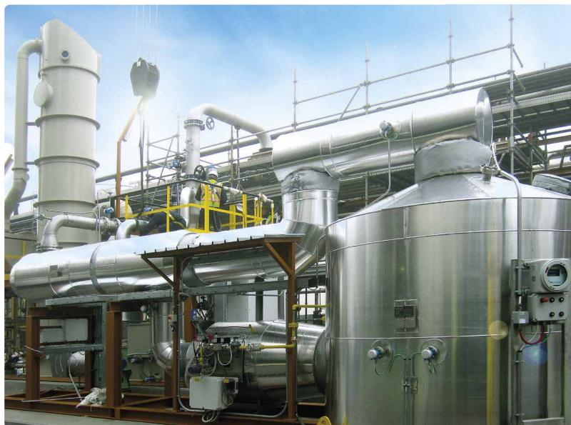
Dank des Vorhandenseins eines oder mehrerer Katalysatorbetten findet die Zerstörung der Schadstoffe bei Temperaturen zwischen 300 °C und 500 °C statt. Die Niedertemperatur-Katalysereaktion macht dieses Verfahren aufgrund der daraus resultierenden Betriebskosten besonders interessant.
