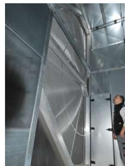
Rotationswärmetauscher in großer Dimension mit sehr hohem Wirkungsgrad
