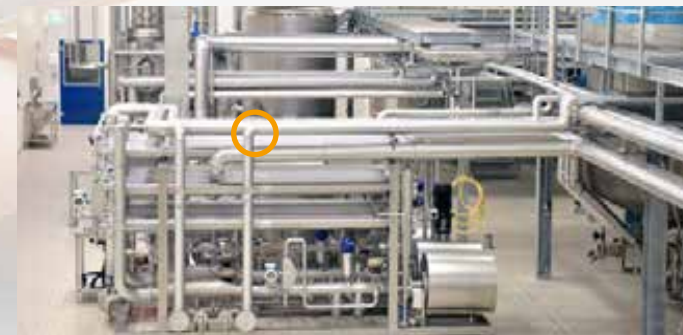
Überprüfung von Schweißnähten in Edelstahlrohren
